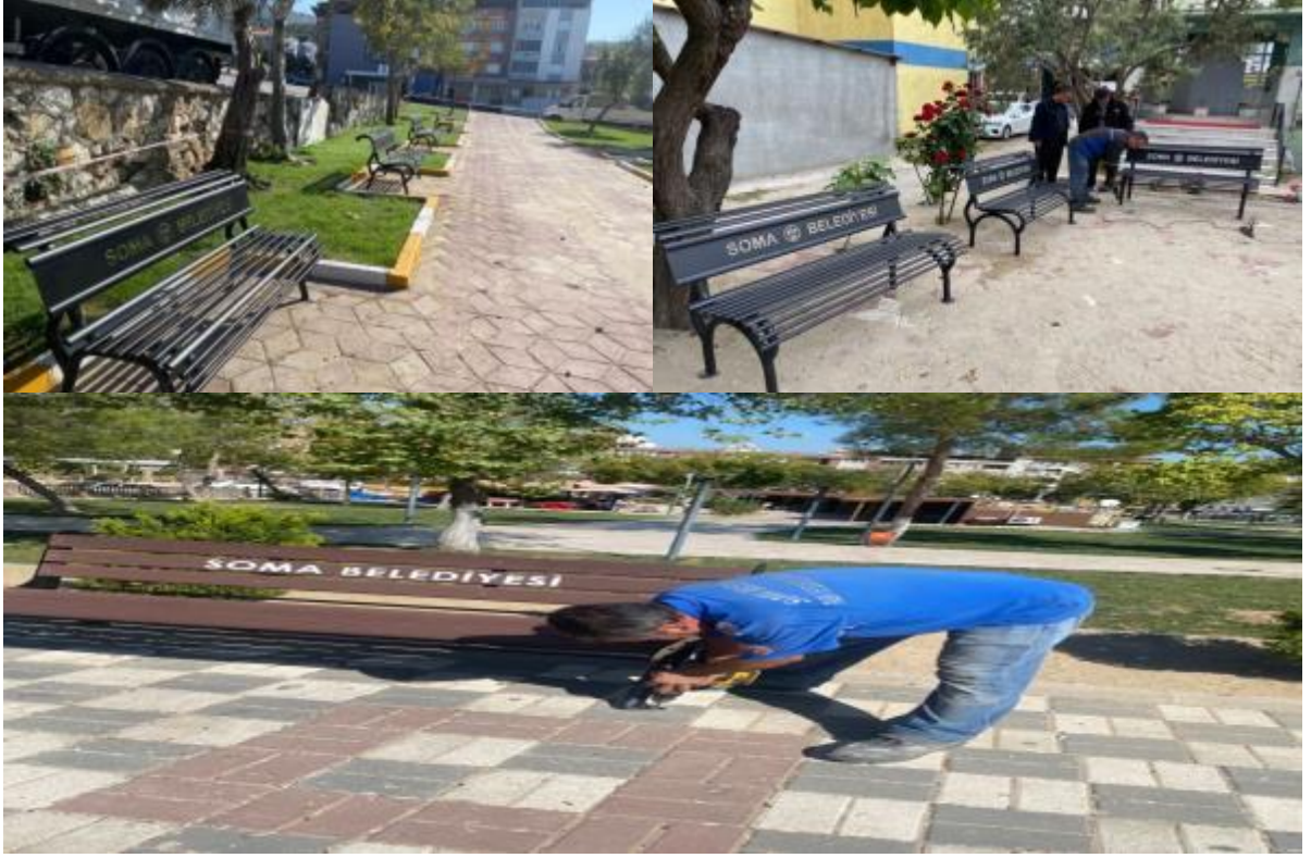
Yeni Kurulan Oturma Bankları Montaj Çalışmalarından Bazı Görüntüler
